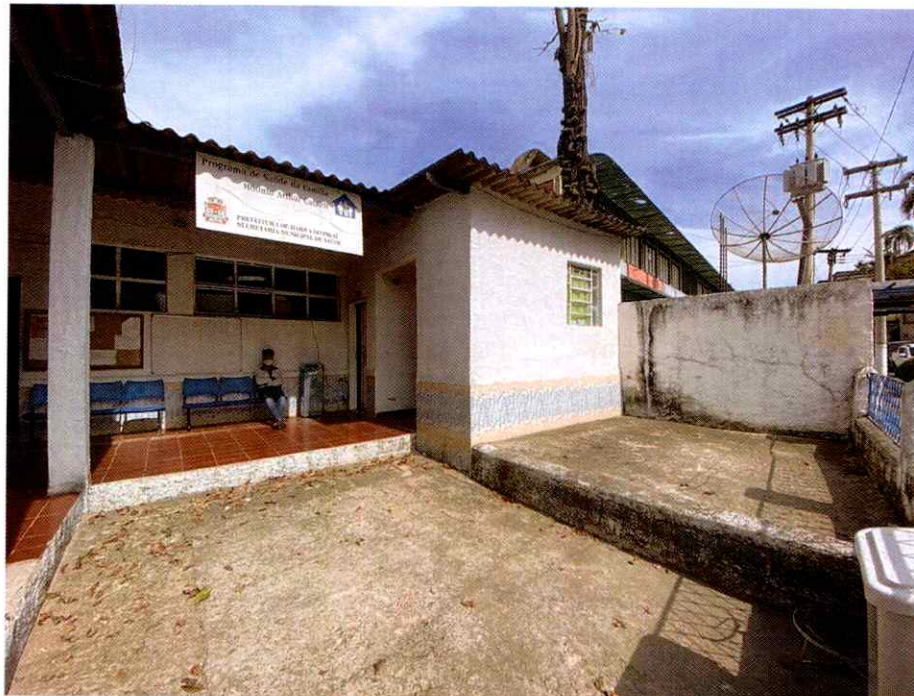
Figura 2 - Perspectiva da fachada – PSF existente Bairro Arthur Cataldi
