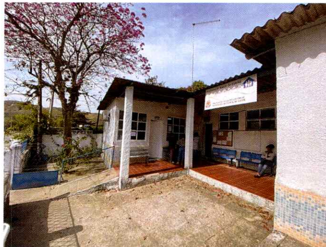
Figura 1 – Perspectiva da fachada – PSF existente Bairro Arthur Cataldi
