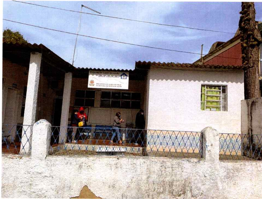
Figura 1 - Vista da fachada – PSF existente Bairro Arthur Cataldi
